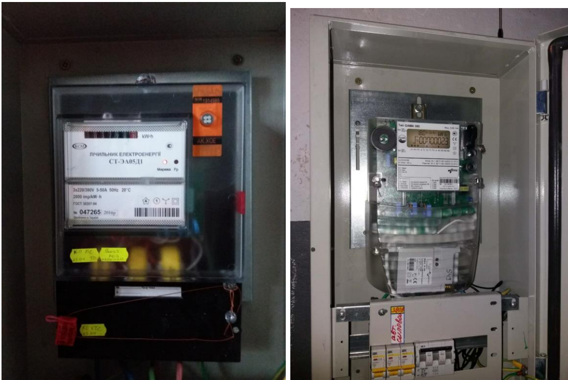
Фото 29-30. Прилад обліку електричної енергії на котельні за адресою вул. Єнакіївська, 19 до початку реалізації контракту та після виконання монтажних робіт.
