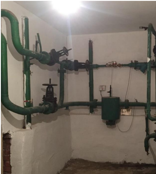
Фото 20-21. Індивідуальний тепловий пункт у ж/будинку за адресою вул. Франтішека Крала, 5 до та після виконання монтажних робіт
