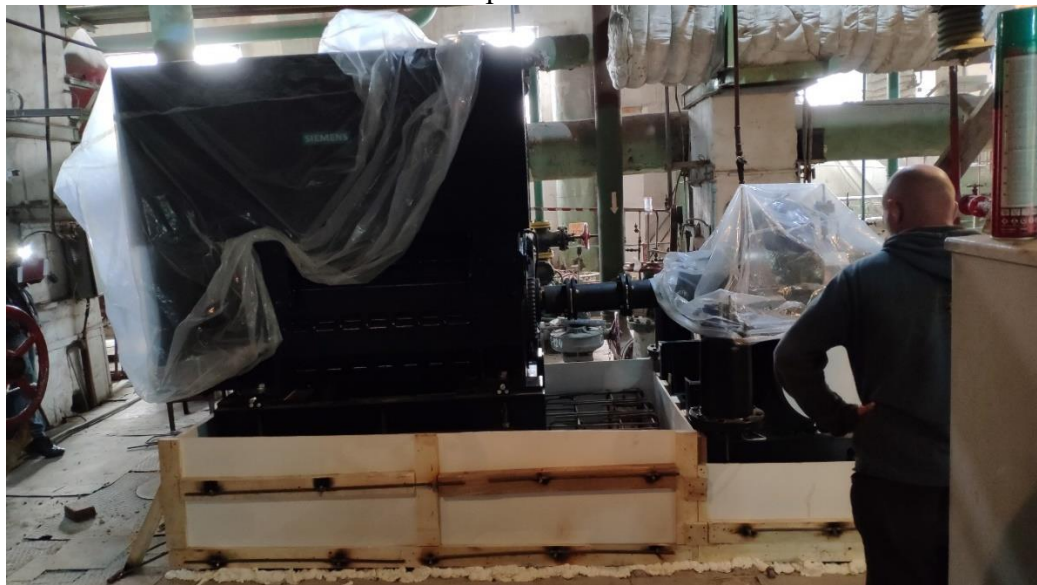
Фото 20. Початок монтажних робіт на піковій котельні ТЕЦ-4, пр. Московський, 275
