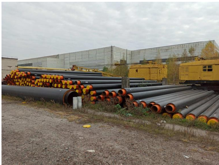
Фото 1-2. Доставлені попередньо-ізолювані труби та інше обладнання
