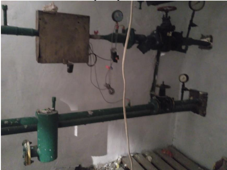
Фото 16-17. Індивідуальний тепловий пункт у ж/будинку за адресою вул. Селянська, 36 до та після виконання монтажних робіт
