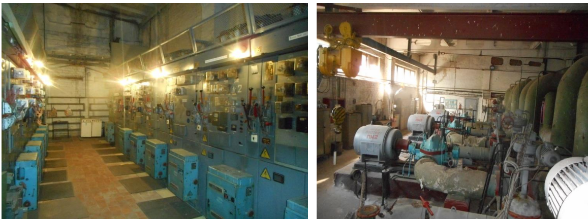
Фото 21-22. Насосна №4-1 за адресою вул. Клочківська, 325А до початку виконання робіт
