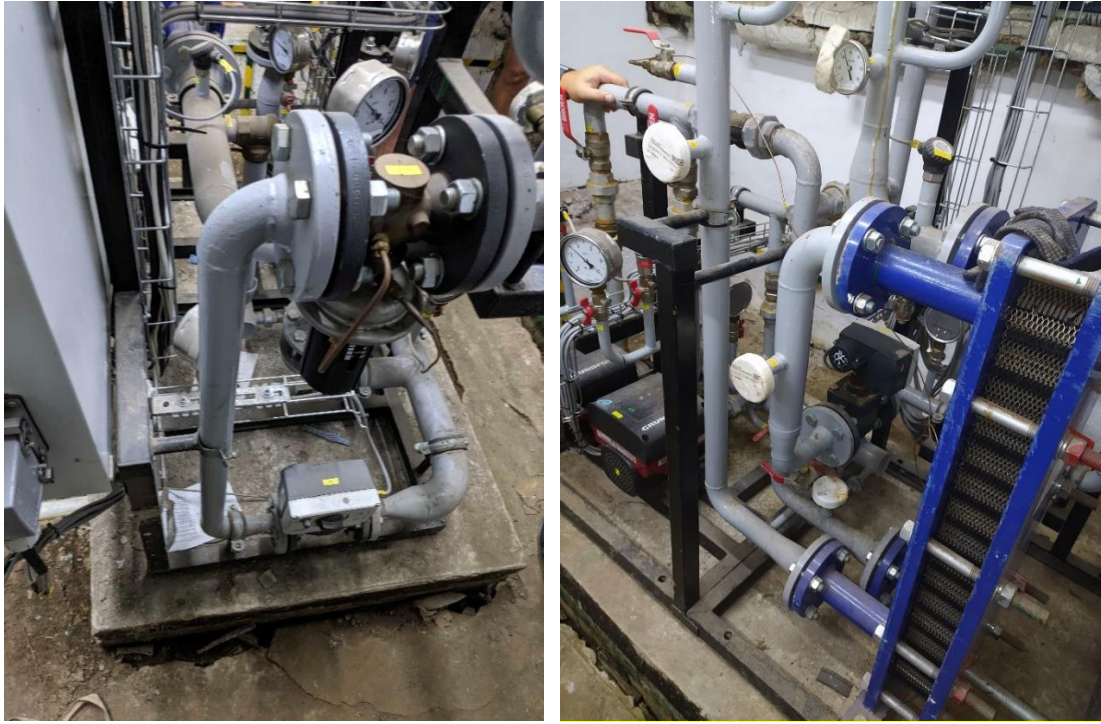
Фото 22-23. Виконання монтажних робіт, встановлення індивідуального теплового пункту в ж/будинку вул. Косарева, 48
