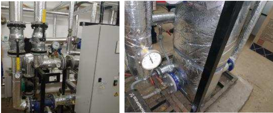
Фото 65-69. ІТП в ж/будинку за адресою пр. Льва Ландау, 56/3 до та після виконання монтажних робіт.
