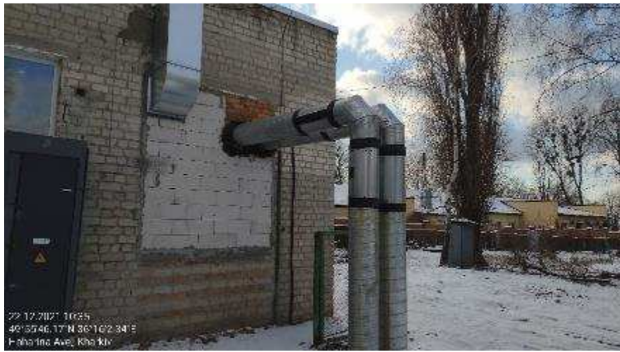
Фото 103-110. Влаштування ЦТП та прокладення нової теплової мережі в період виконання робіт та після їх завершення.
