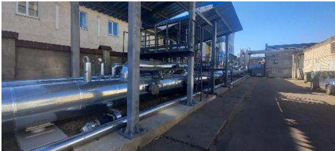
Фото 134-135. Магістральна камера 1210 до та після виконання монтажних робіт.
