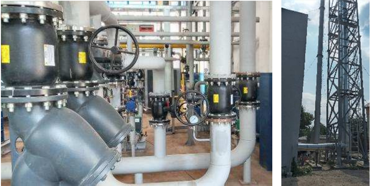
Фото 19-27. Котельня за адресою вул. Велика Панасівська, 29 в період виконання та після завершення будівельно-монтажних робіт.
