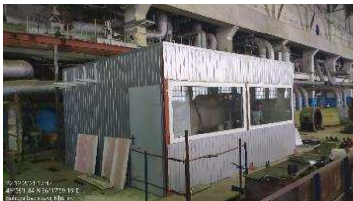
Фото 86-88. Монтажні роботи на майданчику ТЕЦ-3.
