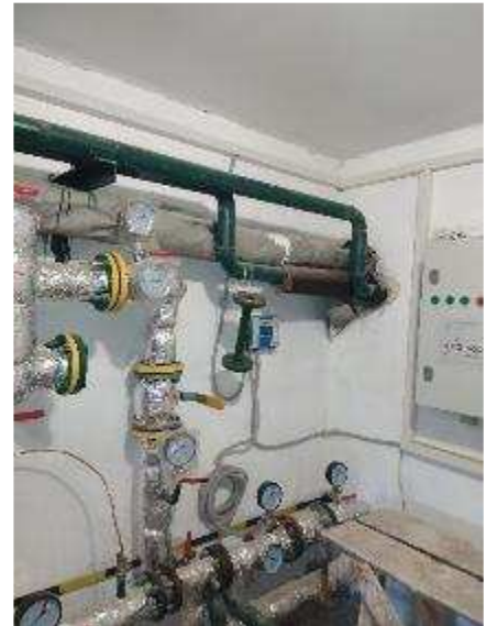
Фото 130-133. Теплової пункт в ж/будинку за адресою вул. Селянська, 34 до після виконання робіт.
