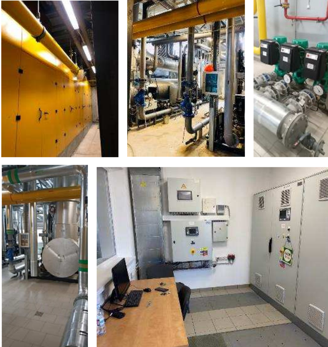
Фото 10-18. Ділянка будівництва когенераційної станції на котельні по вул. Артема Веделя, 4 до початку та після завершення будівельних робіт.
