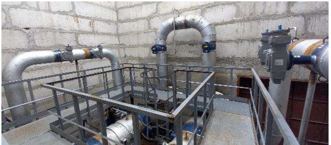
Фото 140-142. Магістральна камера 8611 до та після виконання монтажних робіт.
