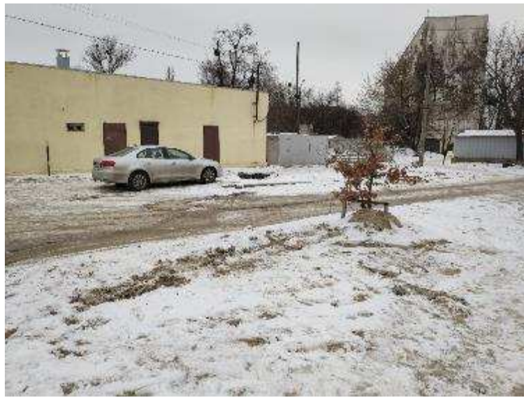
Фото 124-129. Прокладення нової теплової мережі в період виконання робіт та після їх завершення.
